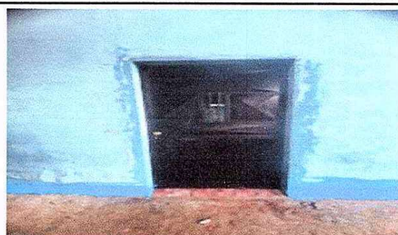
Foto 2: FINALIZACION DE PUERTA
