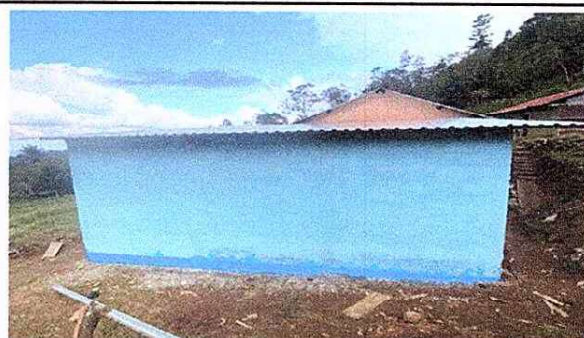
Foto 4: FINALIZACION DE PARED DE AULA
