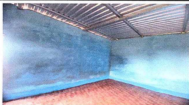
Foto 3: FINALIZACION DE PISO EN EL AULA
